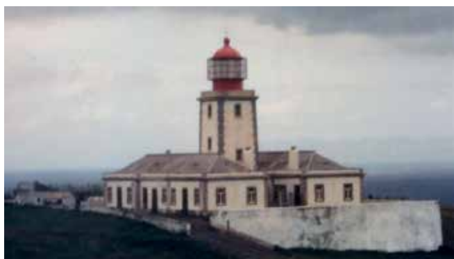
Fotos da Construção e da destruição do Farol da Ribeirinha
