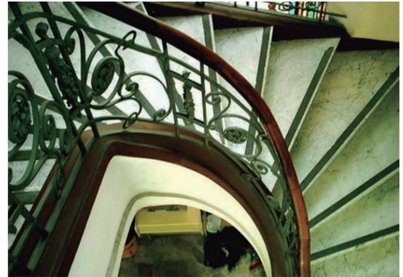
Figura 8: Escada principal da Agência - piso em mármore carrara e guarda-corpo estilo Art Nouveau, em ferro fundido. Foto: MACHADO, 2006.
