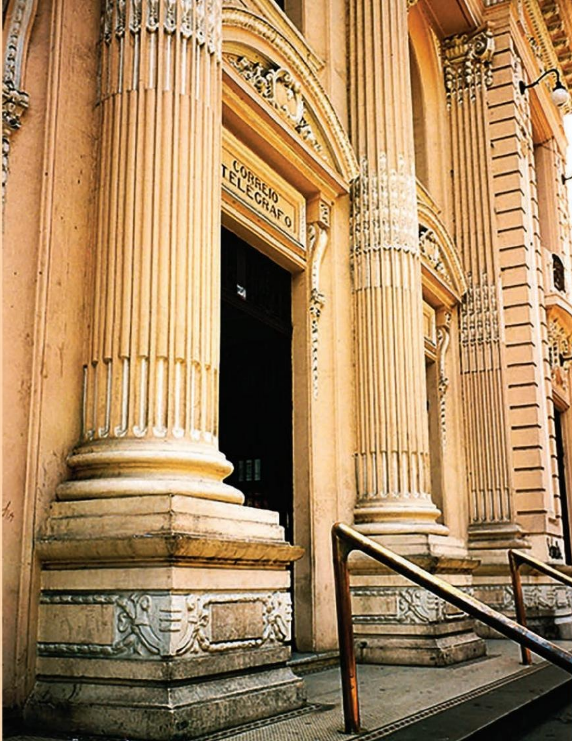
Fachada Agência Central de Petrópolis/RJ
