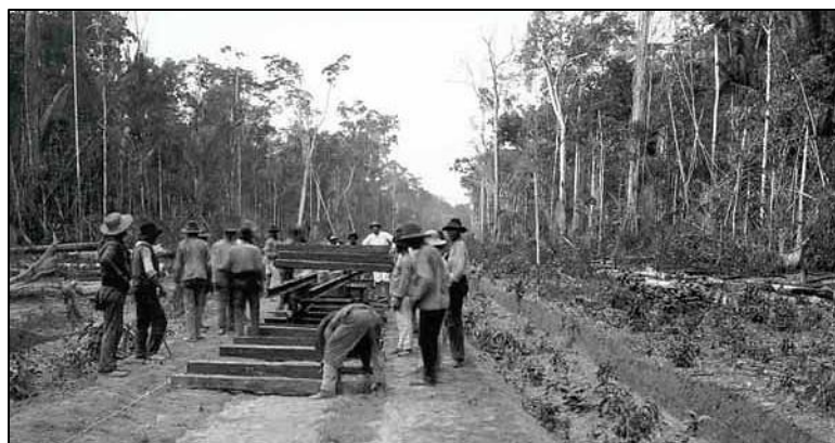
Trabalhadores assentando trilhos da EFMM
